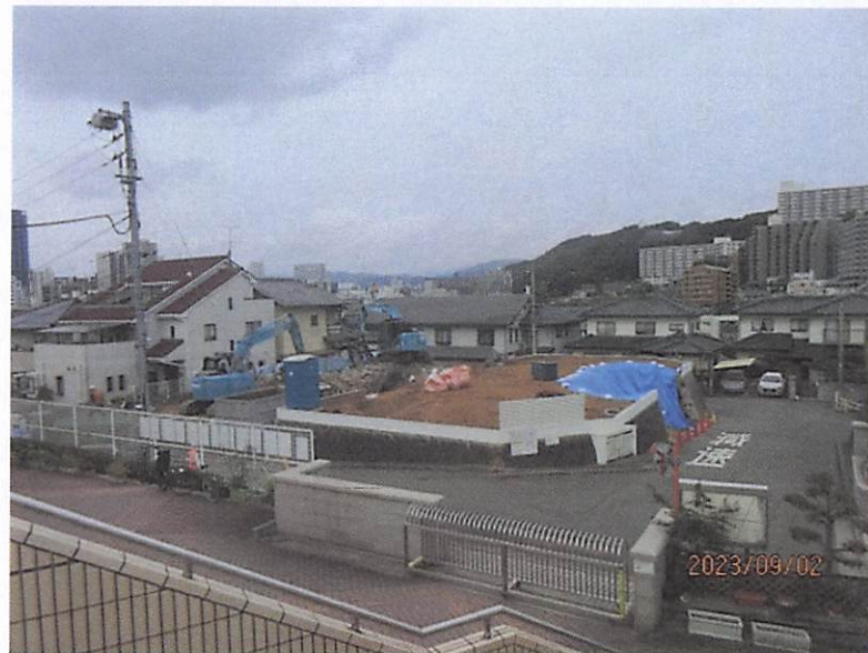
解体後の整地風景(令和5年9月)
