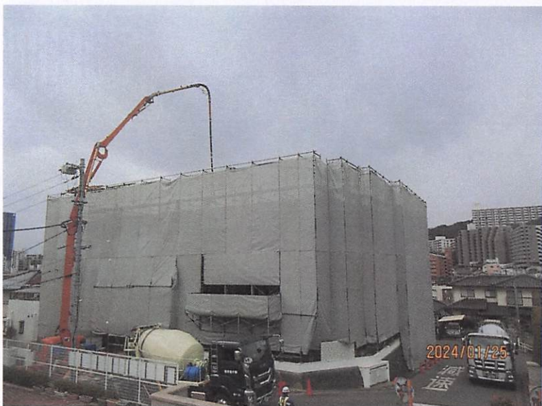
順調に進む建築工事(令和6年1月)
