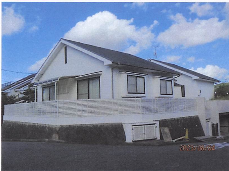
解体前の2棟 当院正門前 (令和5年8月)
