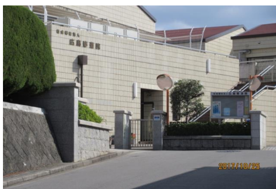
⑯左手の門からお入りください 入って右手の建物が事務所です
